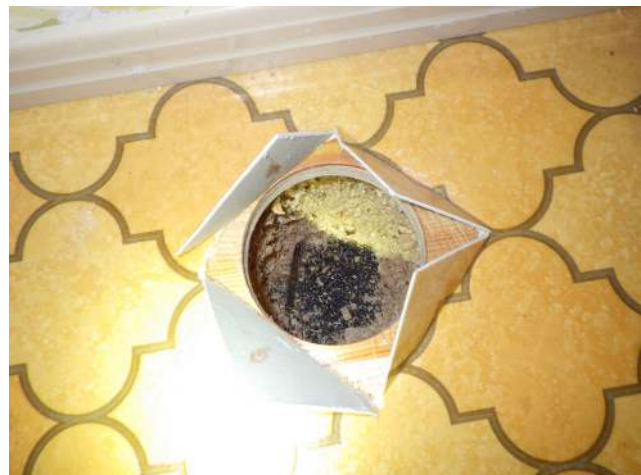
4. Puukoolatun lattiarakenteen rakenneavausta
