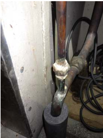
37. Käyttövesijohdon korroosiota
